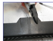
Aussparungen für Kabeleintritt ausschneiden
